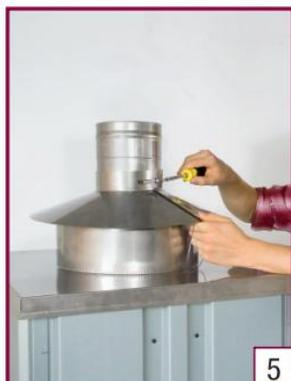
1. Setzen Sie die Kopfabdeckung auf und befestigen Sie diese mit geeigneten Blechtreiberschrauben oder Blindnieten an den Bekleidungspaneelen (Abb. 1 und 2).
