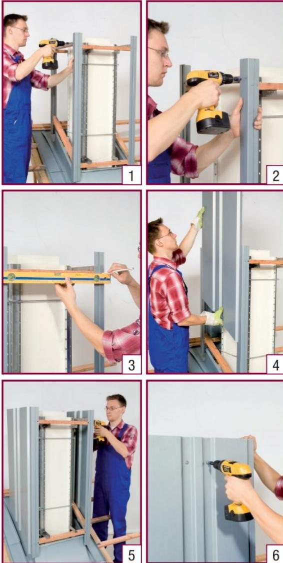
1. Messen Sie die erforderliche Höhe der Verkleidung auf der kurzen und der langen Schachtseite vom Anschlussrahmen bis zur Schachtoberkante. Längen Sie die Eckprofile und die vorderen und hinteren Seitenwände der Stülpkopfverkleidung entsprechend ab. Die seitlichen Verkleidungen kürzen Sie entsprechend der Dachneigung.
