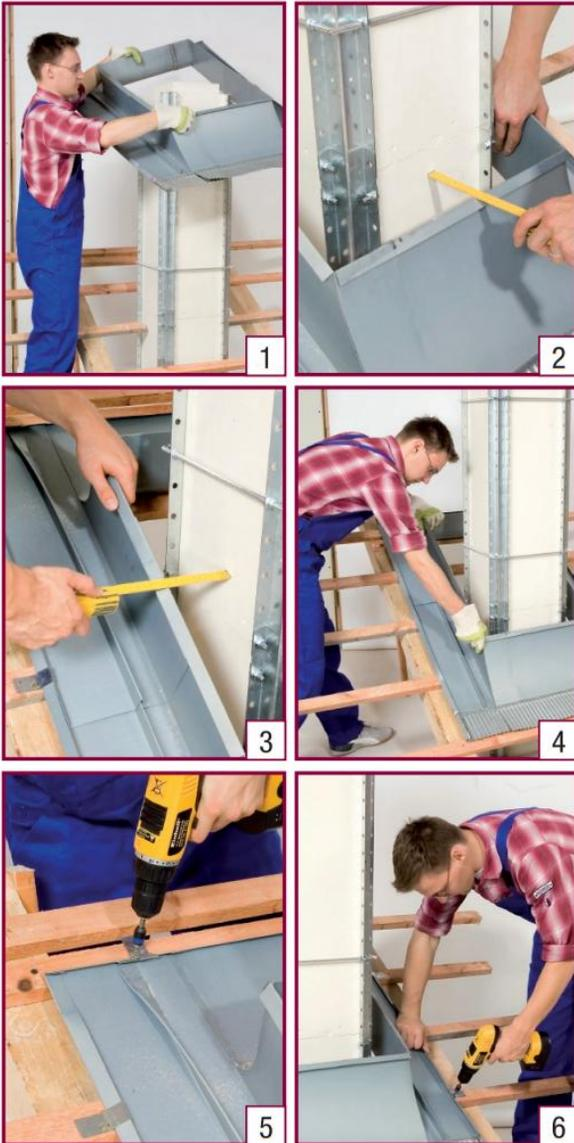
1. Führen Sie den Anschlussrahmen von oben über den Schacht (Bild 1). Bei sehr hohen Dachüberständen können Sie den Anschlussrahmen komplett auseinanderziehen. Die beiden Teile lassen sich dann um den Schacht herum wieder zusammenstecken.
